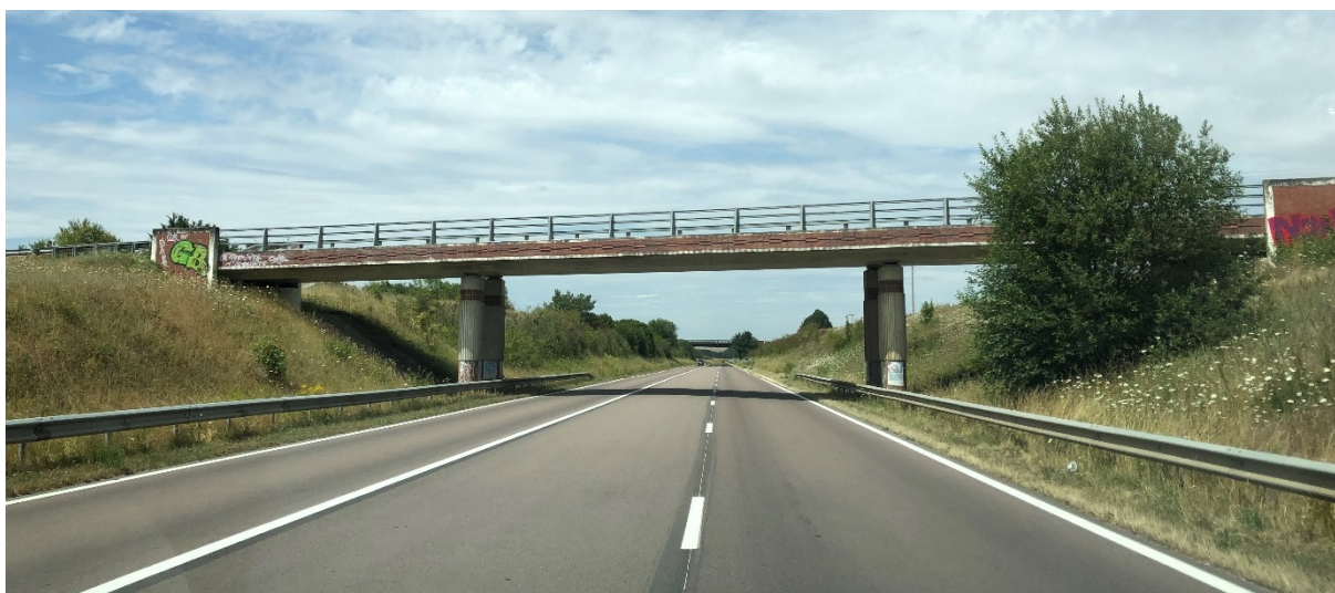
Pont à poutres © Djamel Ferrand - DGSCGC
