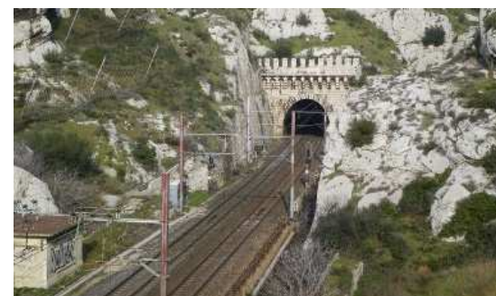
Le tunnel de la Nerthe ©inventaire des tunnels ferroviaires de France
