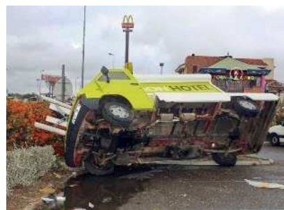
14 octobre 2012 : une tornade balaie la zone commerciale de Plan-de-Campagne (Cabriès). Les dégâts matériels sont estimés à plusieurs millions d'euros. Source: L'OBS
