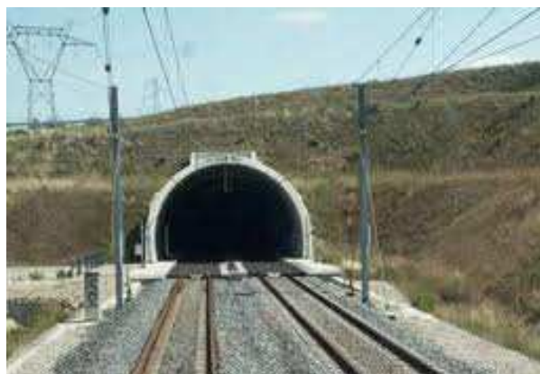
Le tunnel LGV ©inventaire des tunnels ferroviaires de France
