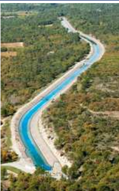
Canal de Provence
