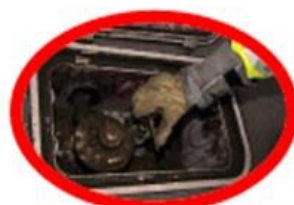
Organe de coupure générale coffret sous trottoir ou coffret en façade
