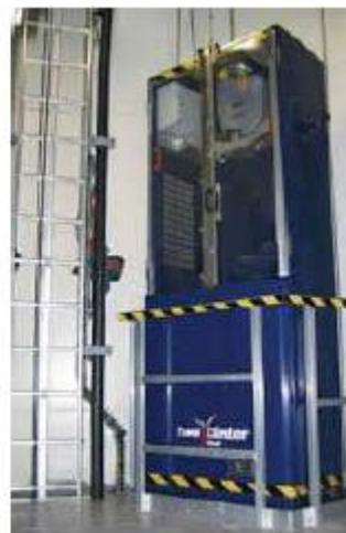
**Une échelle fixe** est installée du bas de l'éolienne jusqu'à la nacelle. Elle permet un accès aux différents paliers. Elle est munie d'un équipement de protection individuelle contre les chutes de hauteur, généralement un antichute coulissant.
