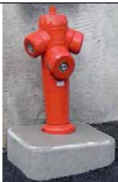
PI avec socle de propreté en béton
