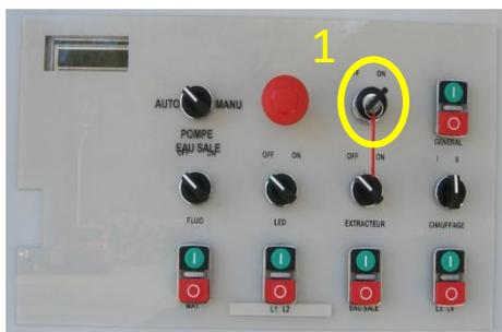
► Positionner l'interrupteur (1) sur « ON ».
