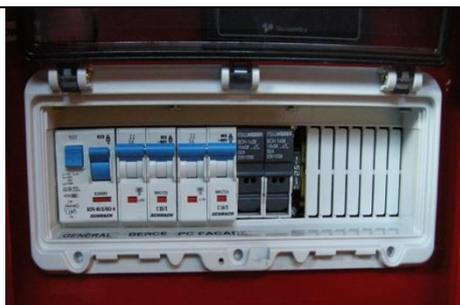
► Relever les interrupteurs disjoncteurs.
