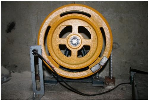
En cas de survitesse (10% de la vitesse initiale) vers le bas, le limiteur, par l'effet de la force centrifuge, se bloque et arrête le câble. La cabine poursuivant sa course vers le bas, le levier de commande du parachute est actionné : un galet, ou un coin d'acier, solidaire de la cabine vient mordre ou pincer le guide. Ainsi, instantanément ou progressivement, la cabine est immobilisée.
