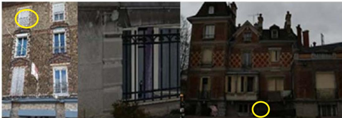
Barreaux aux fenêtres empêchant la réalisation de sauvetage
