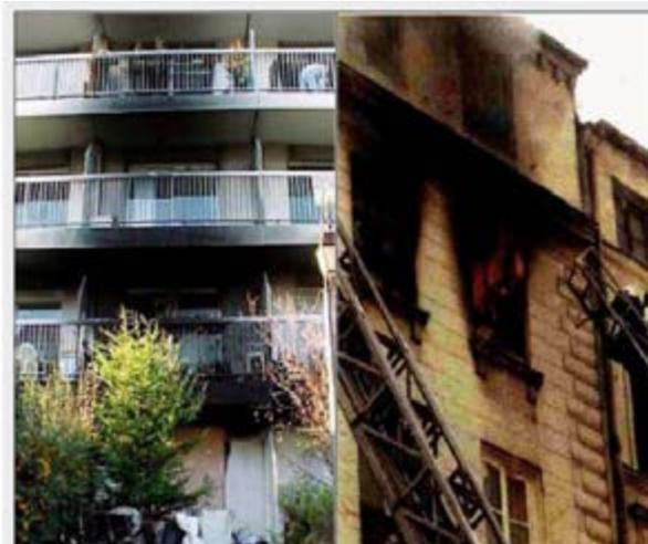
Cette règle offre un obstacle à la propagation du feu par la façade d'un étage à l'autre. Il est défini pour un feu dit «normal».
