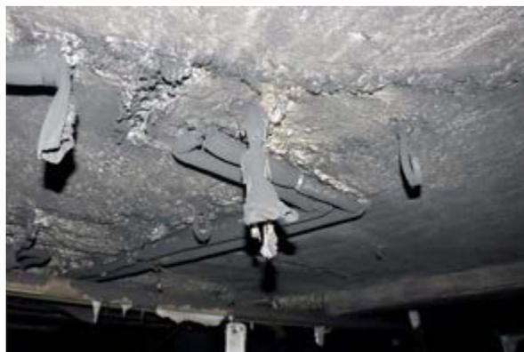
La présence des conduits de PVC dans les PS est à prendre en compte lors d'un incendie. Le PVC se décompose facilement en présence de la chaleur. Le conduit ouvert favorise la propagation de gaz chauds dans les parties communes mais aussi et surtout dans les logements. En 2013 sur une opération, 4 personnes suite à une intoxication ont été retrouvées décédées dans leur appartement.
