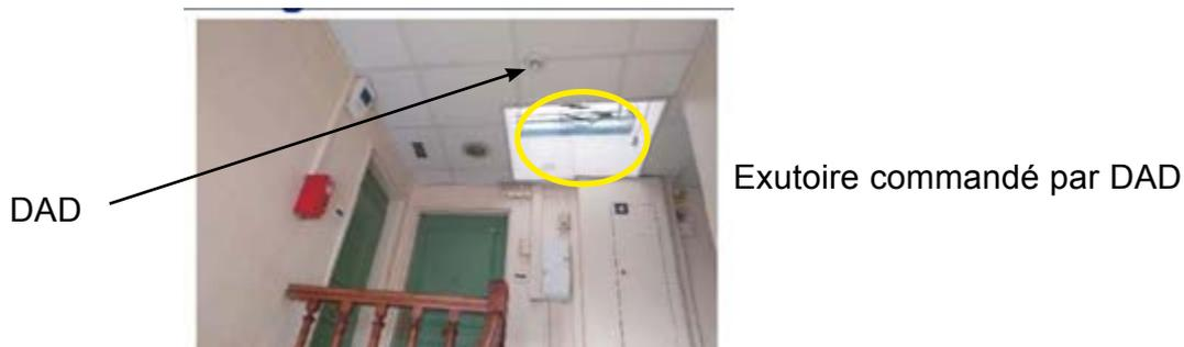
Dans certaine situation, le désenfumage est réalisé par un détecteur autonome déclencheur (DAD).
