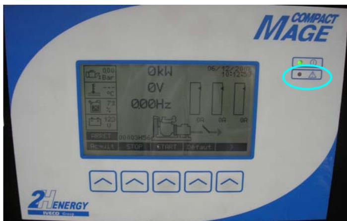
Lors de l'apparition d'un défaut un klaxon type buzzer retentit. Pour l'arrêter, appuyer sur n'importe quelle touche.
