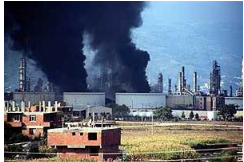
Risque d'explosion dans périmètre proche-IZMIT (1999)
