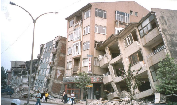
Risque d'effondrement induit par autres bâtiments proches-IZMIT (1999)
