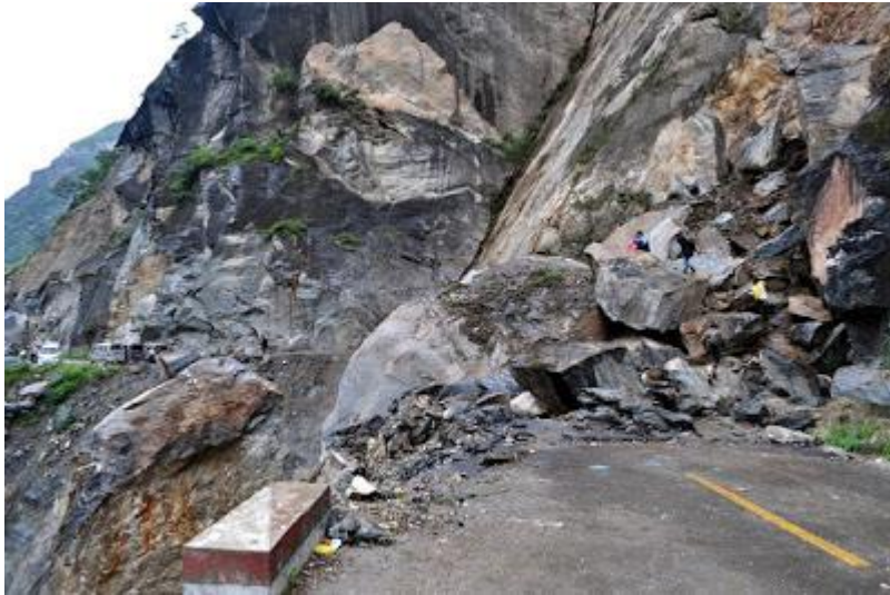
Chute de blocs rocheux
