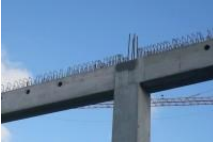
Exemple de liaison encastree poteau-poutres
