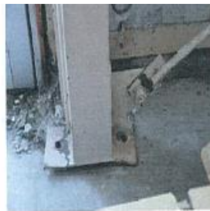
Arrachement des ancrages des pieds de poteaux (semelles)
