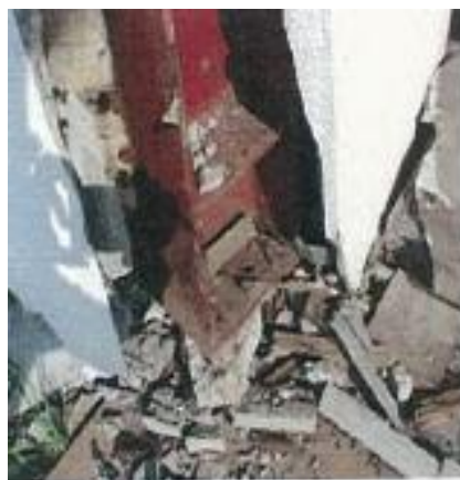
Arrachement des ancrages des pieds de poteaux (semelles)
