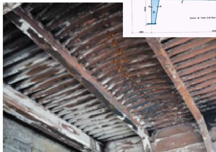
Figures 70 et 71 : Pont Mathilde Rouen – 29 octobre 2012 – accident d'un camion-citerne sur l'ouvrage et propagation de l'incendie sous l'ouvrage.
