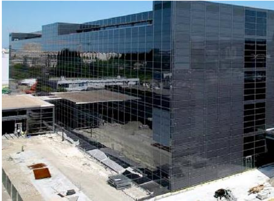
Structure mixte acier-béton, Geneve
