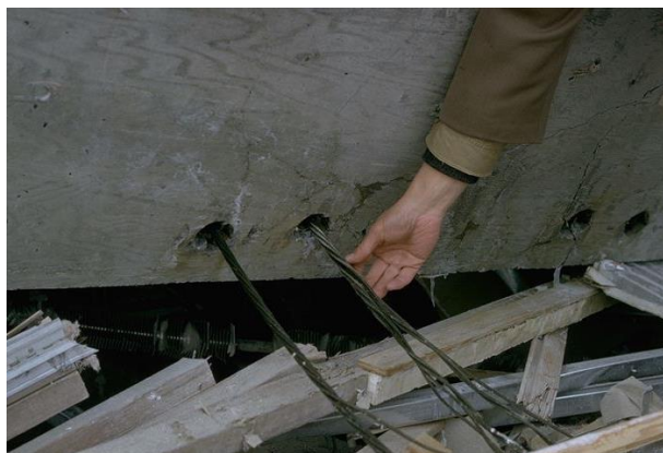
Rupture des câbles de pré contraintes entraînant la dislocation des éléments en béton du pont –Anchorage,1964
