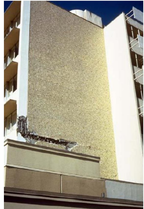
Cisaillement d'un voile suffisamment confiné Californie, 1971
