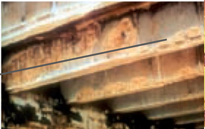
Ecaillage sur poutres et sur poteau
