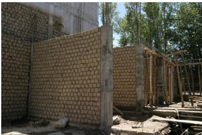
Portiques béton et remplissage briques de terre
