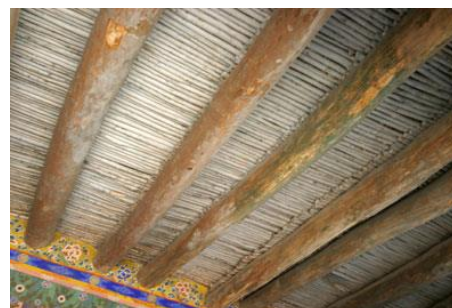
Plancher et toiture en poutres bois et terre
