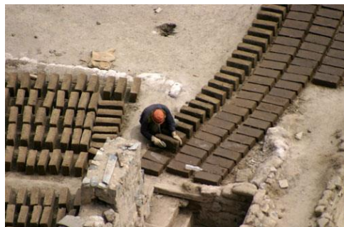
Fabrication des briques de terre crue (ADOBE)
