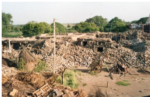
Effondrement du à la dislocation des maçonneries
