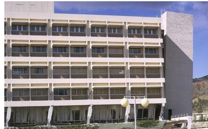
Doc.NISE USA, San Fernando Californie, 1971 Le glissement du bâtiment a été interrompu par la cage d'ascenseur.
