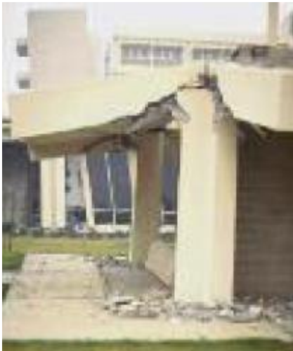
Ruptures des surfaces en porte à faux avec délestage des liaisons sup. des poteaux
