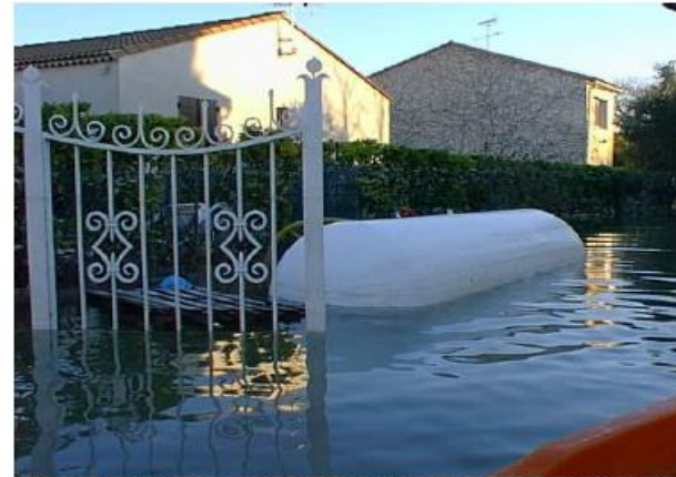
Massifs en BA soulevés par la Poussée d'Archimède (Doc. CSTB)
