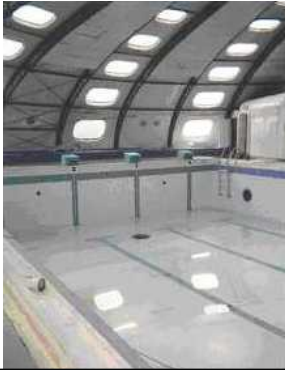
Bassin vidé de piscine Doc.BRGM
