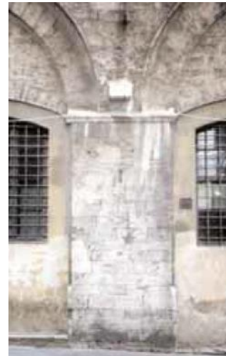
Fissures distribuées sur la surface du pilier
