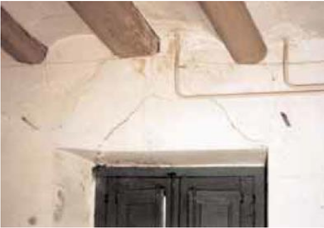
Linteau déformable (fissuration par manque de rigidité)
