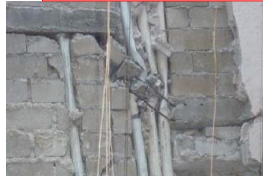
Gouttières encastrées dans remplissage et poutre 2010, HAÏTI doc V. Davidovici
