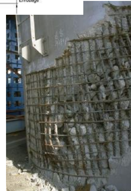
Exemple de bon confinement sur une pied de pile de viaduc, Kobé 1995
