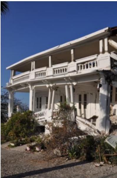
HAITI 2010 Maison de l'ambassadeur de France, 1900
