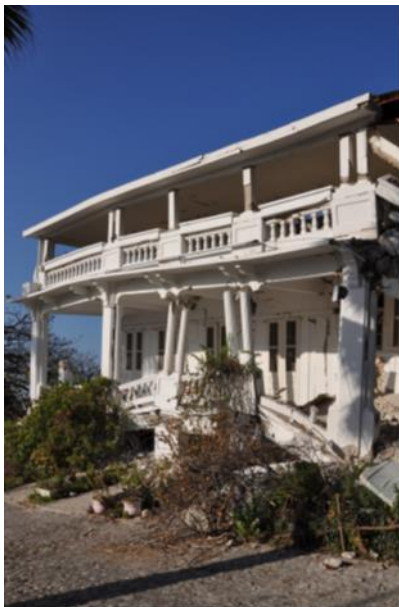
HAITI 2010 Maison de l'ambassadeur de France, 1900
