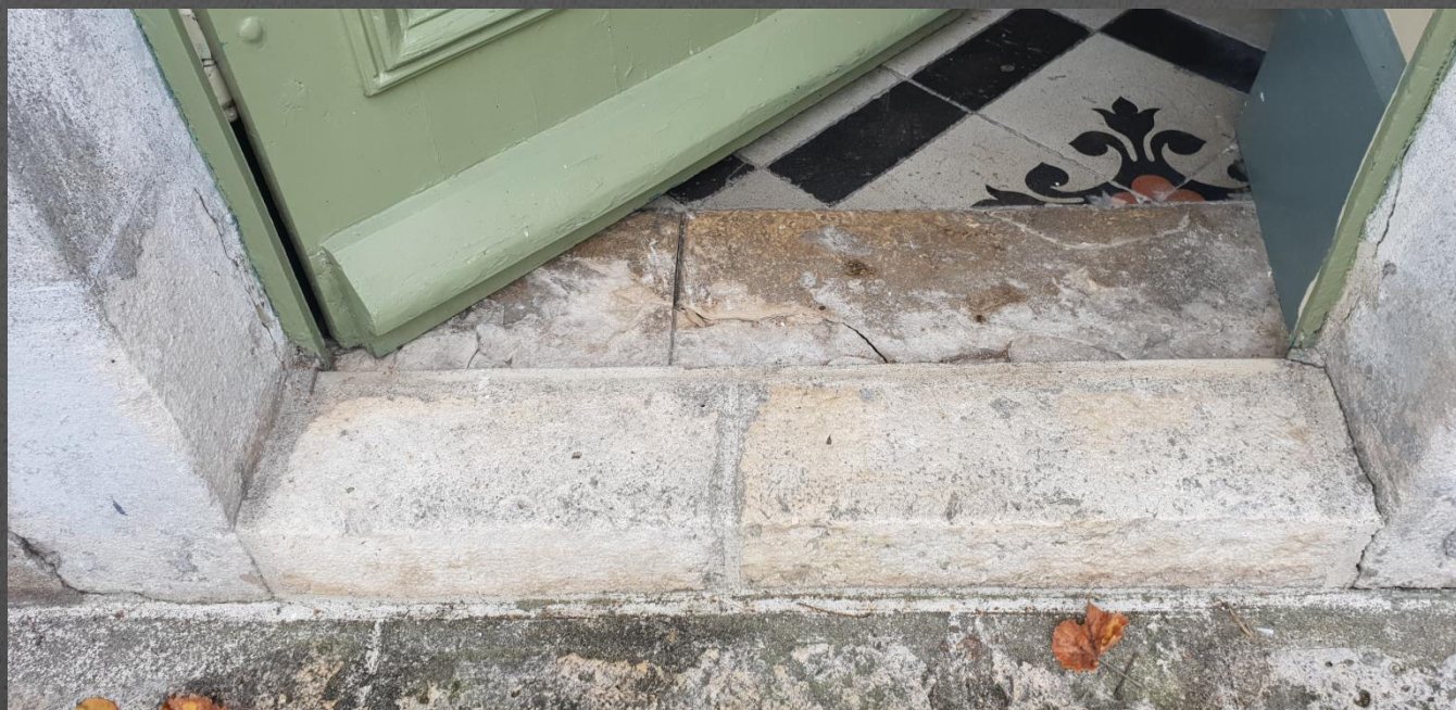
8° observation sur façade Charlie
