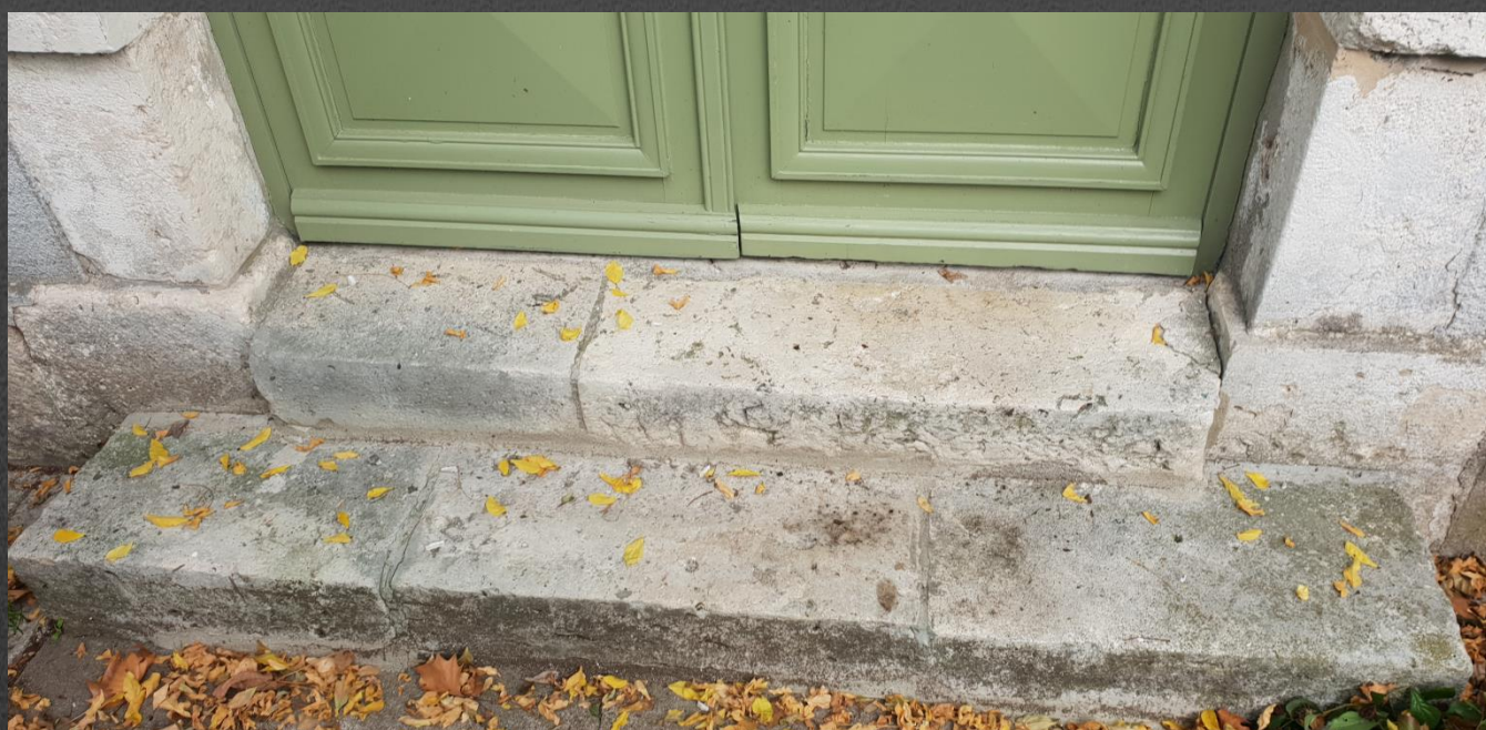
9° observation sur façade Alpha
