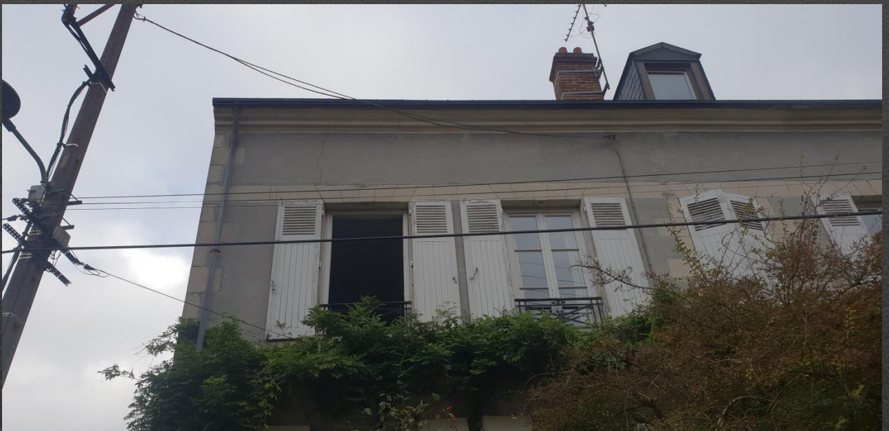
Façade Alpha au 18 rue de Bellebat, 45000 ORLEANS
