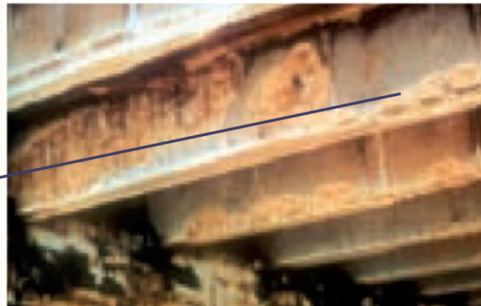
Ecaillage sur poutres et sur poteau
