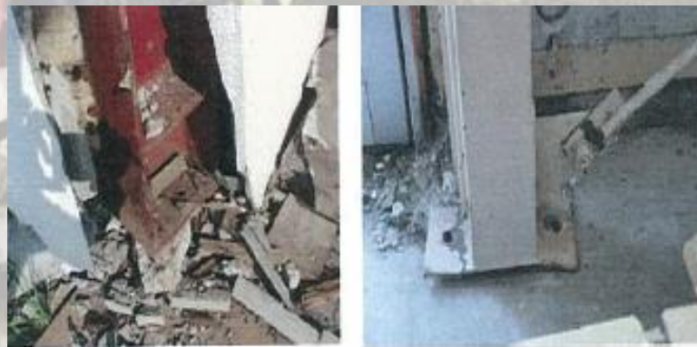
Arrachement des ancrages des pieds de poteaux (semelles)
