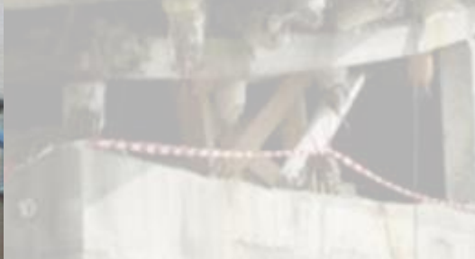
Dislocation à partir des ouvertures non chaînées (+ absence de joint de découplage avec le bâti voisin)
