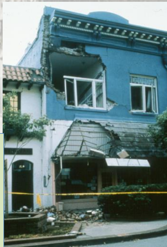
Dislocation à partir des ouvertures non chaînées (+ absence de joint de découplage avec le bâti voisin)
