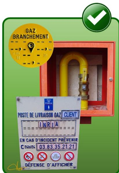
Pour livrer le gaz aux clients, des piquetages d'alimentation sont réalisés sur les canalisations du réseau. Ces piquetages sont appelés **branchements**. Ces branchements peuvent alimenter un particulier, des bureaux, un immeuble d'habitation ou encore des industries.
