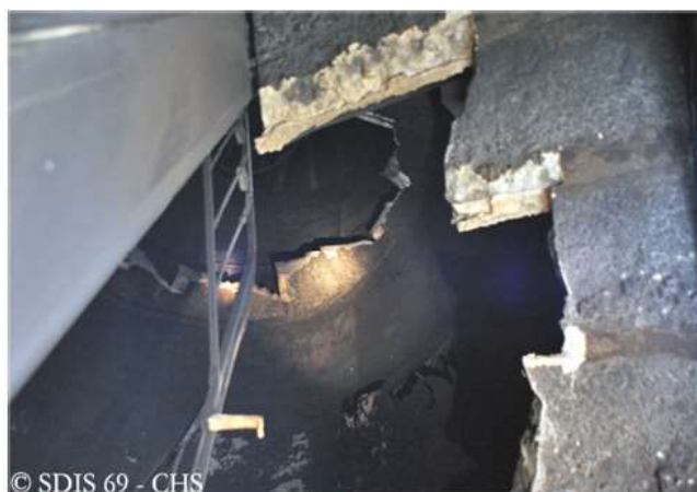
Photos de marches en pierre ayant reçu une contrainte thermique et qui ont fait l'objet d'un éclatement et/ou d'une rupture
