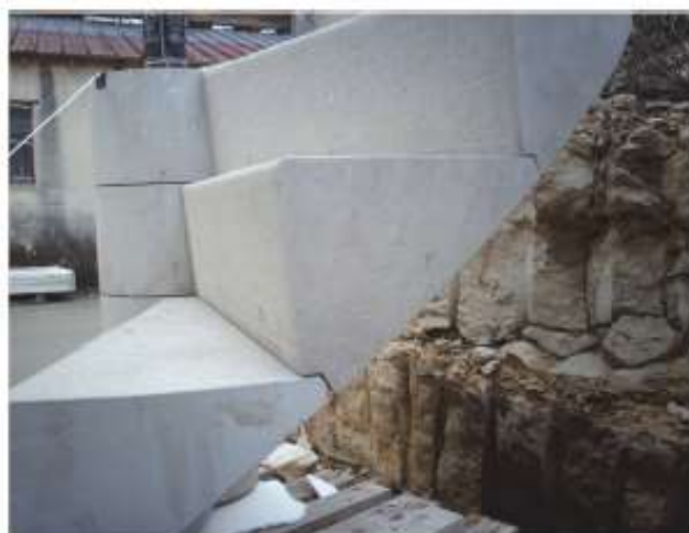
Exemple de construction d'un escalier en pierre
