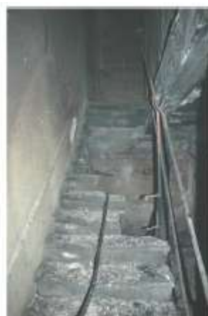
Photos de marches en pierre ayant reçu une contrainte thermique et qui ont fait l'objet d'un éclatement et/ou d'une rupture
