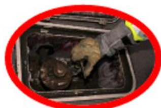
Organe de coupure générale coffret sous trottoir ou coffret en façade
