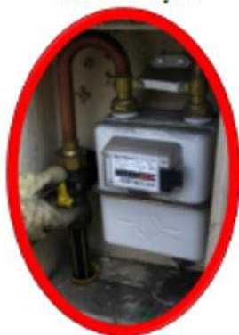
Organe de coupure générale coffret sous trottoir ou coffret en façade
