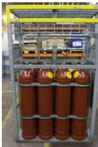
Un cadre de bouteilles connectées entre elles
