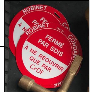
Modèles de dispositif de marquage de condamnation des organes de coupure fournis par GRDF
