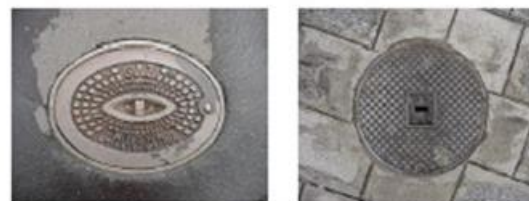
Les vannes réseau
