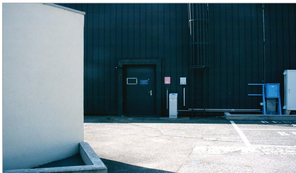
Entrée du local PUI (bâtiment BDS, bloc de sécurité)
