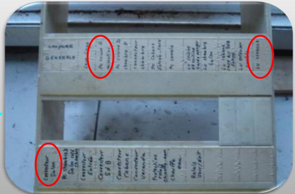
➤ Lors de la coupure de l'électricité, il est recommandé d'activer uniquement le disjoncteur général de façon à conserver la position des autres organes de protection (coupes circuit, disjoncteurs différentiels...)
