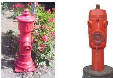
Illustration n°6 : Exemples de poteau sur canalisation de 80
