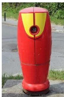
Illustration n°8 : Exemples de poteau sur canalisation de 150
