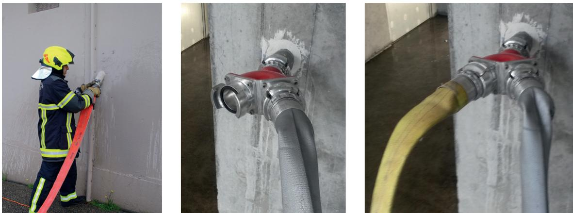
Le conducteur réalise l'alimentation de la colonne sèche située a moins de 20m de l'EPT avec 1 ou 2 tuyaux de 70 de 20 m et l'utilisation d'un collecteur si utilisation de 2 tuyaux.
