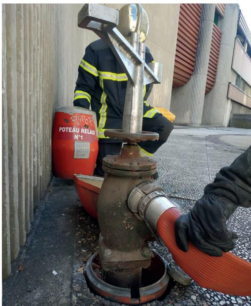
Le binôme au niveau du poteau relais se raccorde pour établir une division d'alimentation d'attaque ou colonne sèche.
