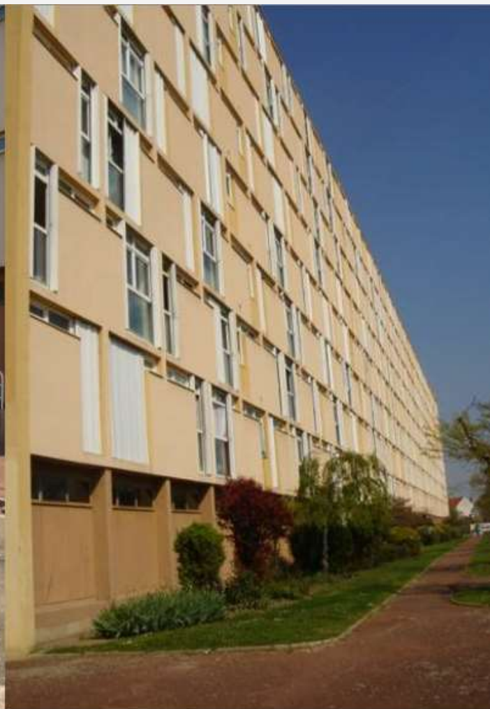
Façade arrière non accessible aux engins de secours
