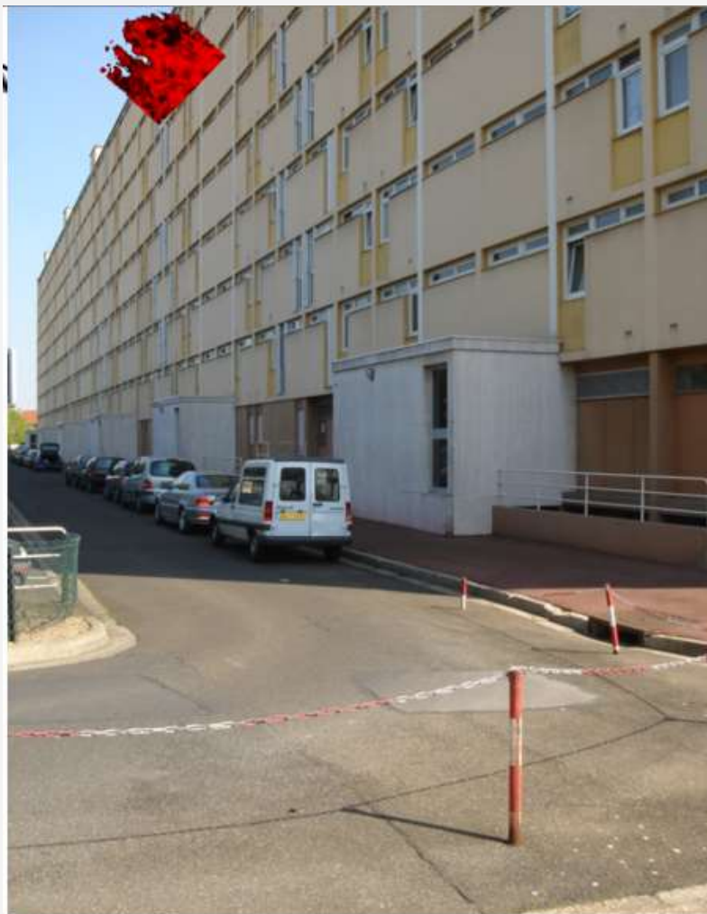
Façade avant avec voie échelle (souvent impraticable)
