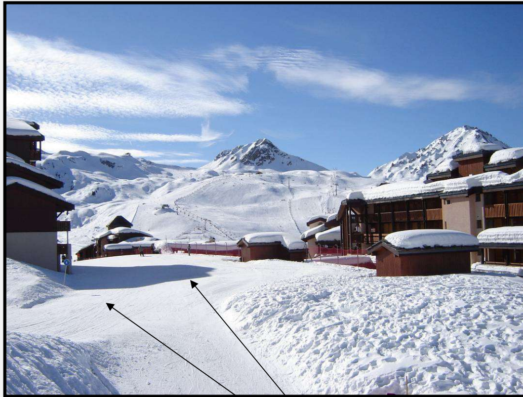
Piste de ski surplombant le parking souterrain
